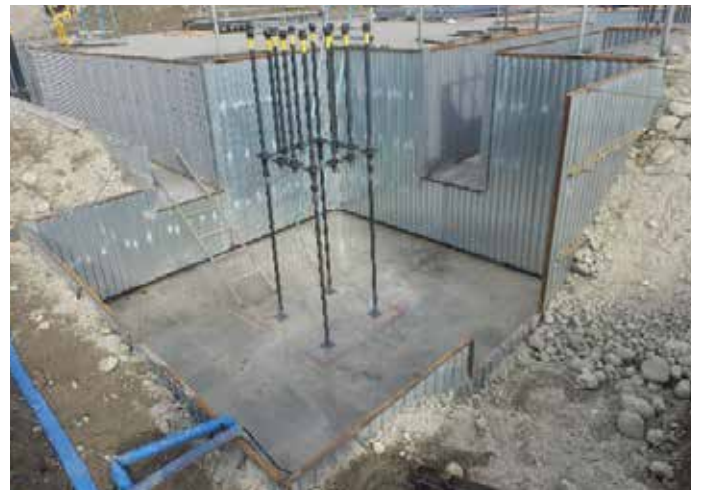
基礎・地中梁部
