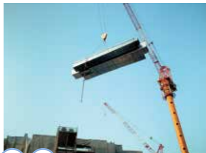
10 11 荷降し・間配り
