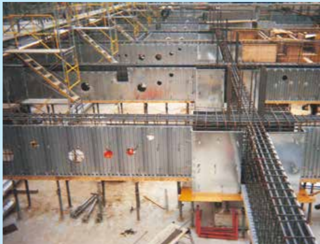
免震用梁の施工例
