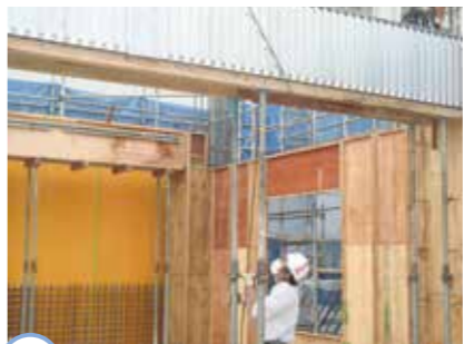
14 仮支保工の設置
