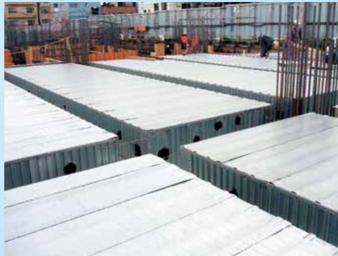
梁、床ともに打込み型枠で施工した例
