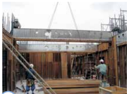
13 クレーンを使用して柱型枠に取付
